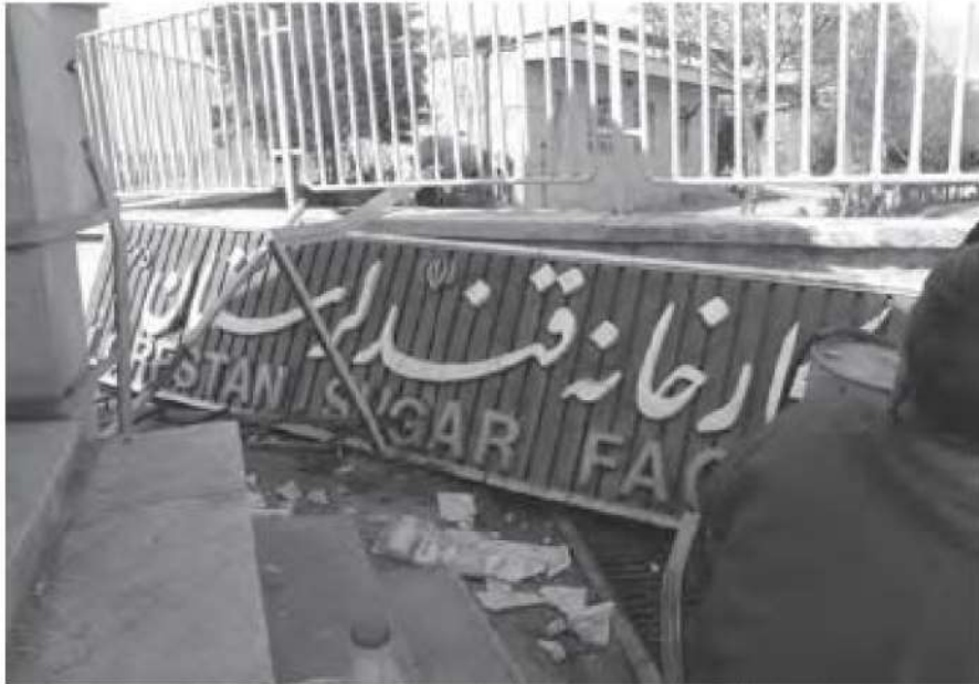
نمونه‌ای از خسارات وارد شده به تابلوها در زلزله ۱۳۸۵ استان لرستان
